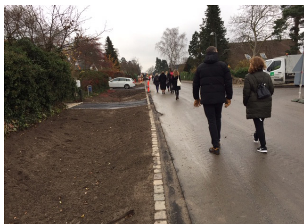
Fortove er fjernet til fordel for render til regnvandshåndtering.
