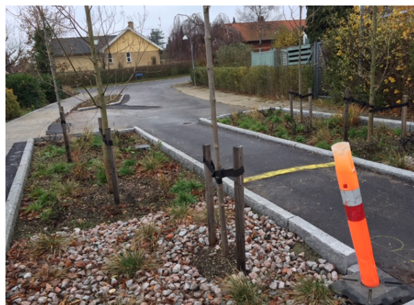
Træplantninger i vejarealet ved Enebærvej i Furesø Kommune. I vejbed er anvendt pimpsten, og der er gummimembran i bunden.
